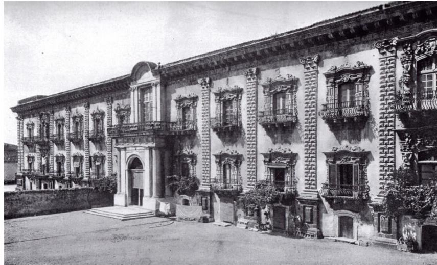
MONASTERO DEI BENEDETTINI — FACCIATA PRINCIPALE.
